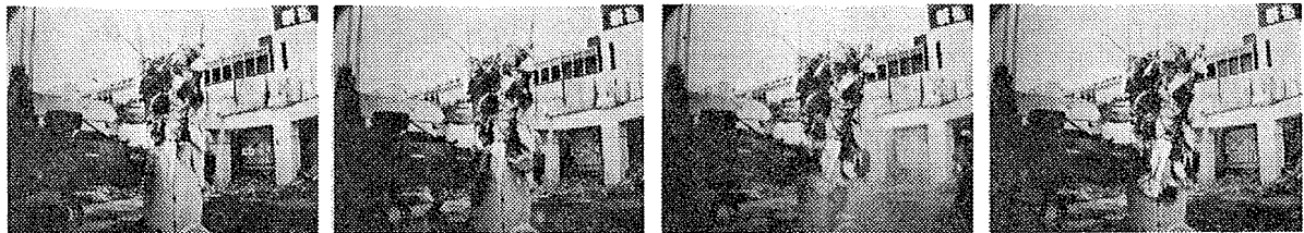
写真-4 RC 柱の破碎状況 (←メモーション法)
