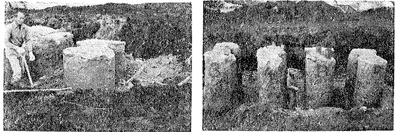
写真-1 固結パイルの掘削状況
