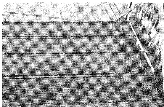
写真-2 散水流下式集熱器の外観(タイプII)
