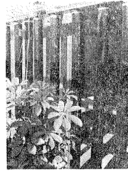
写真二2 温室の中の潜熱蓄熱体
