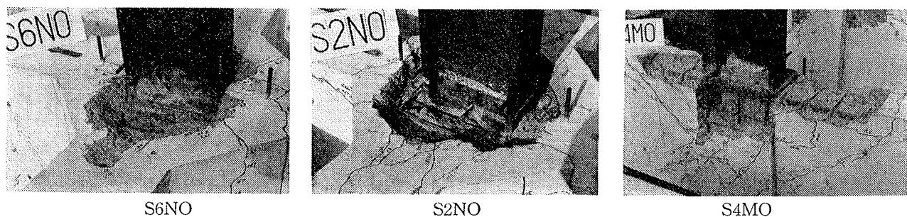
写真-1 破壊状況
