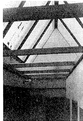
写真-2 天窓の状況 (断熱板設置前)
