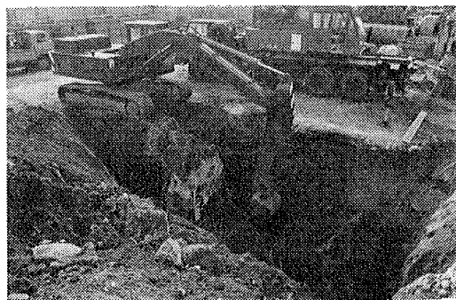
写真-1 試験体の掘出し
