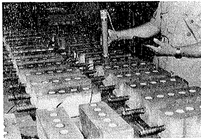
写真-1 自然電位測定状況
