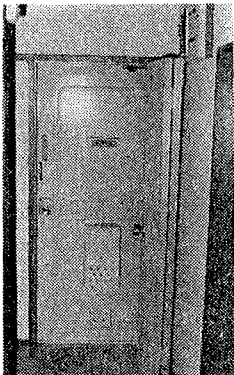
写真-8 玄関の内扉 取付
