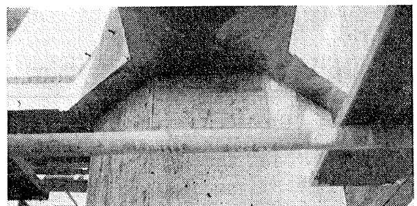
写真一2 柱・はり接合部の仕上り状態
