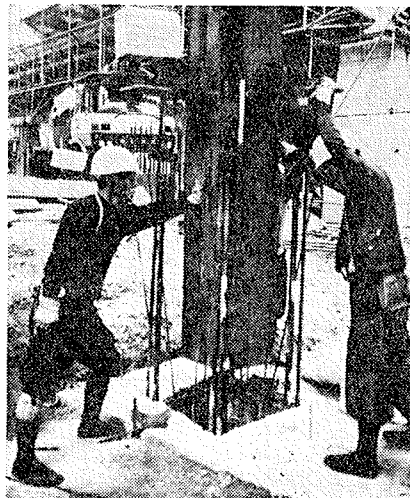
写真三 鉄骨柱の建方
