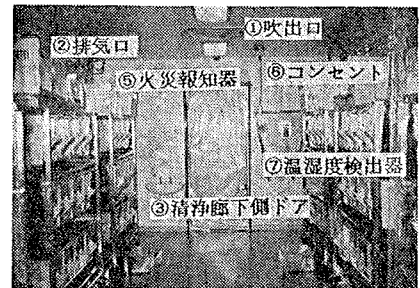
写真一 室内のシール状況
