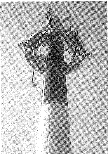
写真一7 円周方向繊維巻き付け
