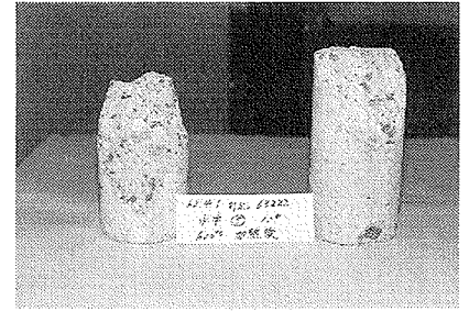
写真-3 爆裂現象
