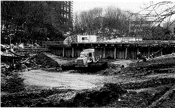
写真-2 ソイルライマーによるヘドロ固化工事
