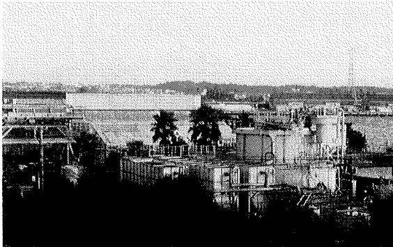
写真-1 処理プラントの全景
