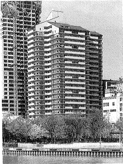
写真-1 建物外観
