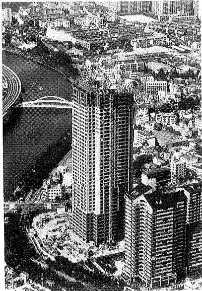
写真-1 建物の全景
