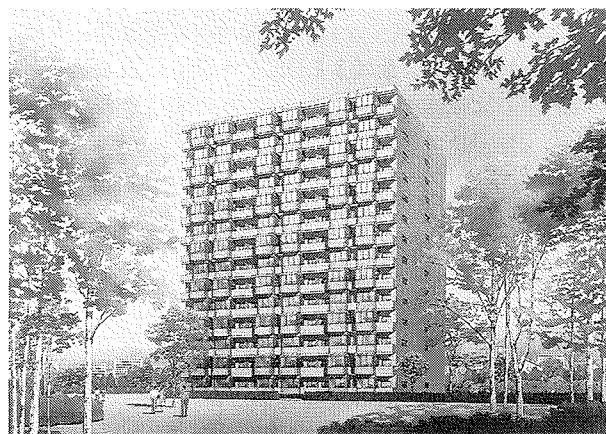
写真一4 建物全景
