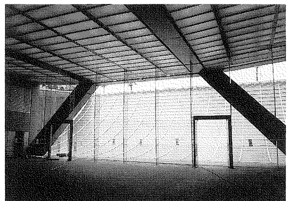
写真-4 1階エントランスロビー(高さは2層分)
