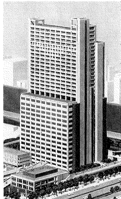
写真-1 A 建物外観 (33階建, 延床69.397 m 2 )
