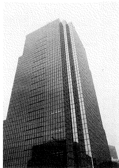
写真-2 B 建物外観 (22階建, 延床33.846 m 2 )
