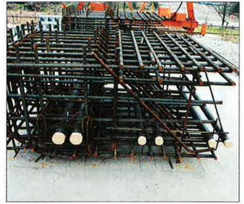
写真-1 実規模過密配筋モデルの配筋
