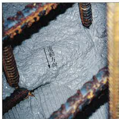
写真-6 鉄筋周囲の流動状況
