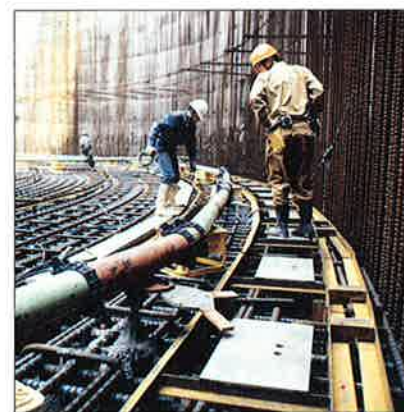
写真-5 ゲートバルブからの打設状況
