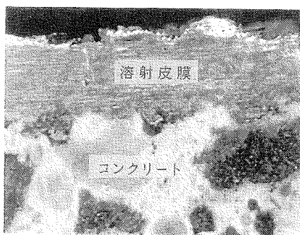
写真一2 溶射皮膜断面の様子 (フレーム溶射, アルミ)
