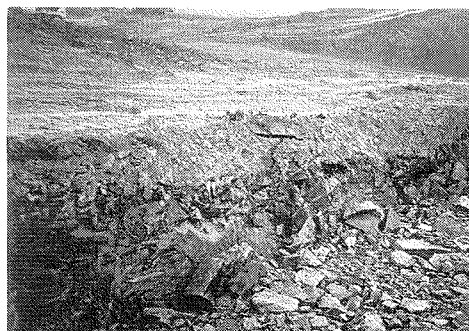
写真-3 盛土状態
