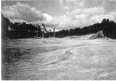
写真-5 張シバ後7カ月経過した状態
