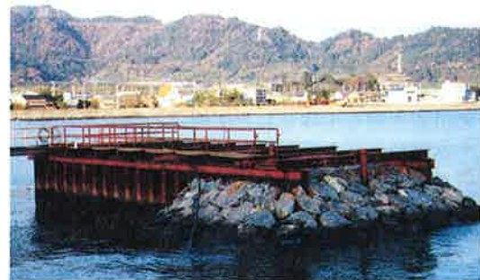
写真-1 石積み浄化堤の現地実験施設の全景
