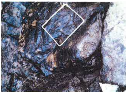
写真-5 造成後2カ月における内水域側被覆石の表面 (生物膜)
