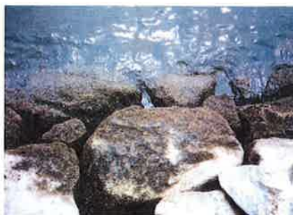
写真-6 造成後2カ月における外水域側被覆石の表面 (大型生物)
