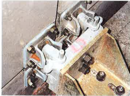
写真-1 A型ファスナーの使用状況
