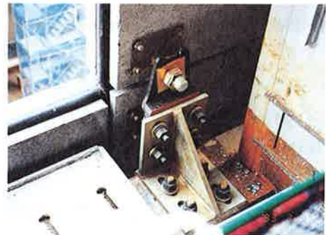
写真-2 B型ファスナーの使用状況
