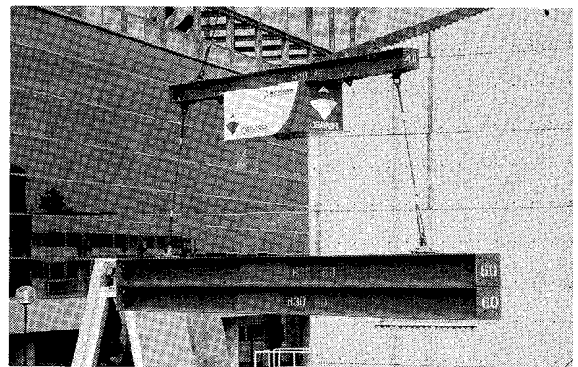
写真-1 ジャイロモーメントを利用した吊荷制御装置
