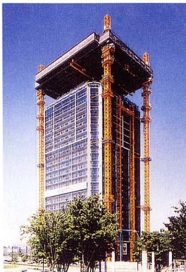
躯体、設備、仕上工事 (23階躯体施工時)
