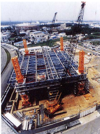
仮設架構の組立
