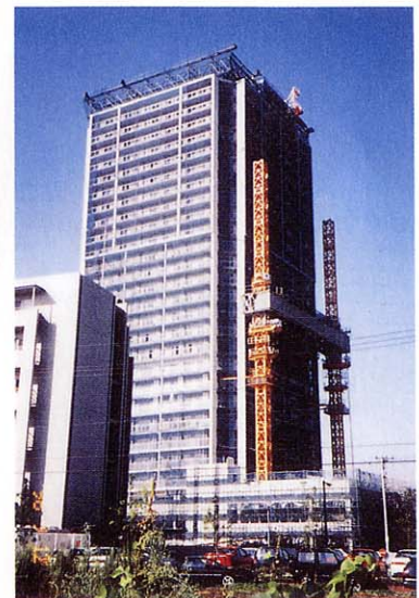
屋根架構解体、逆クライミング
