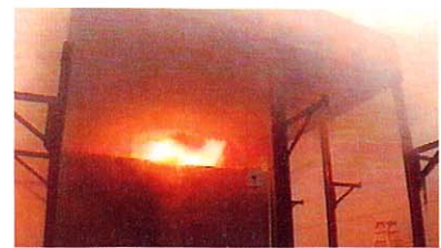
Photo 6 トラス下部からの火炎噴出 Blowing of Flames under the Truss
