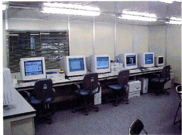
Photo 6 制御室 Control Room
