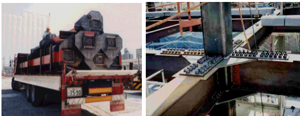
(a)車上の積載状況 (b)接合部の組上り状況 Photo 2 鉄骨造ノンウェルド工法の適用 Application of Non-Weld Steel Structure System
