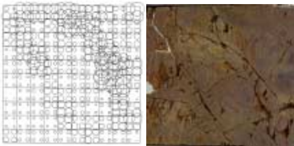
Fig.12 せん断ひずみ分布(左)とき裂状況(右) (B2ブロック供試体#2面)
