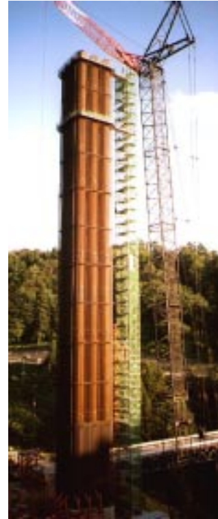
Photo 1 鋼管コンクリート複合構造橋脚 The Construction of Composite Steel-Tube Reinforced Concrete Columns
