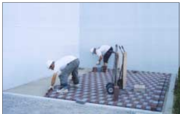
Photo 5 試験施工(敷設状況)
