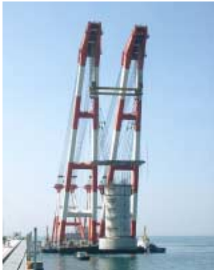
Photo 1 スカート基礎据付状況 Installation of Skirt Foundation
