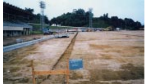
Photo 2 給水側溝設置 床付け Water Supply Canal
