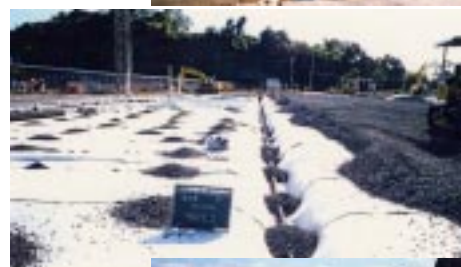
Photo 5 クッションマット、排水 管・排水層 Mat, Drin Pipe & Gravel Layer
