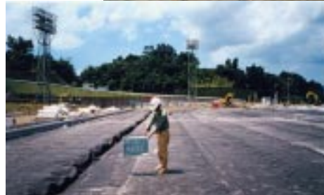
Photo 3 遮水シート敷設 Permeability Sheet
