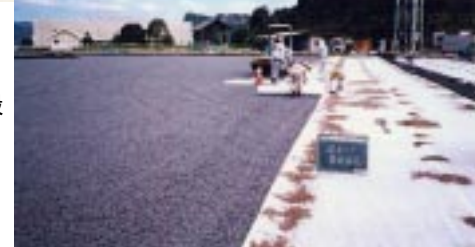
Photo 6 透水シート敷設 Sheet Setting
