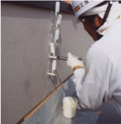
Photo. 6 ひび割れへの注入状況 Injection Epoxy Resin to Crack
