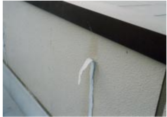
Photo. 4 仮シールを剥がした状況 Under Remove the Sealant
