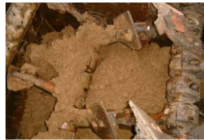
Photo 1 2軸ミキサ - による攪拌の様子 Agitating by Two Shaft Mixer
