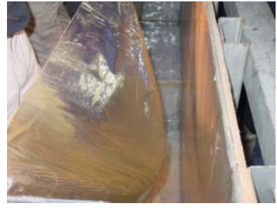
Photo 4 FRPシートの張付け Laying Prepreg
