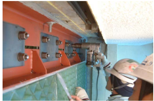
Photo 14 FRP 壁板と周辺架構との一体化処理状況 Joint of Guide-Steel and FRP Wall
