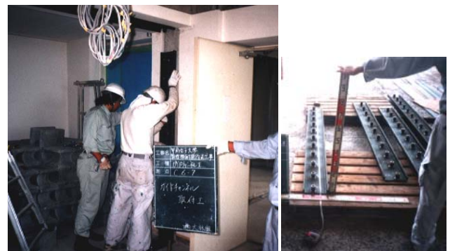
Photo 5 ガイドスチールの取付け Setting of the Guide-Steel
