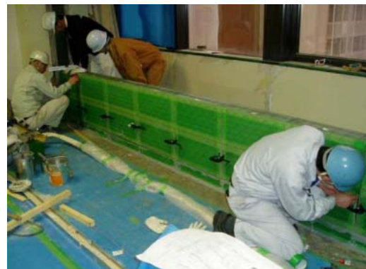
Photo 13 ブロック組積状況 Laying up FRPBlocks
