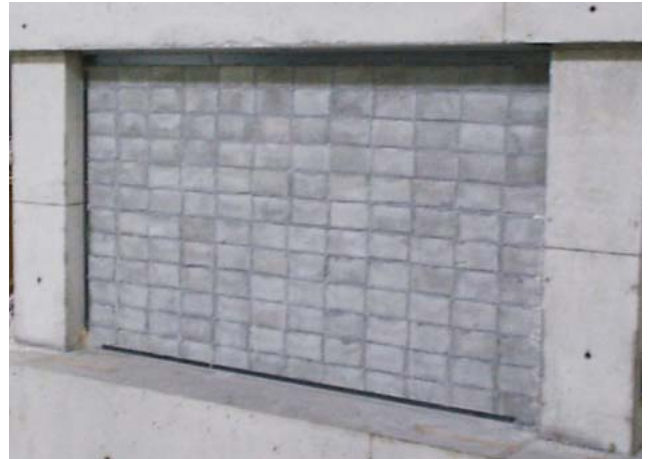
Photo 1 PCa ブロック耐震壁の外観 Appearance of PCa-Block-Wall
