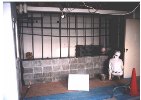
Photo 6 PCa ブロックの組積 Laying up PCa Blocks
