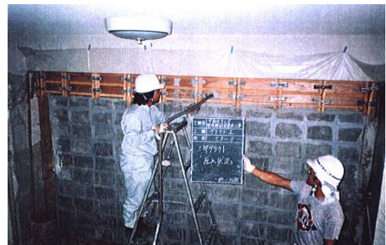
Photo 7 グラウト状況 Grouting
