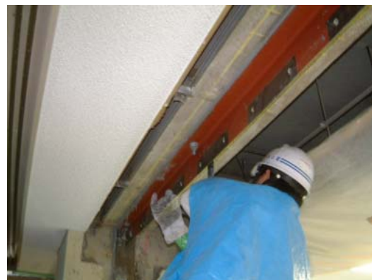
Photo 12 ガイドスチールの取付け Setting of Guide-Steel
