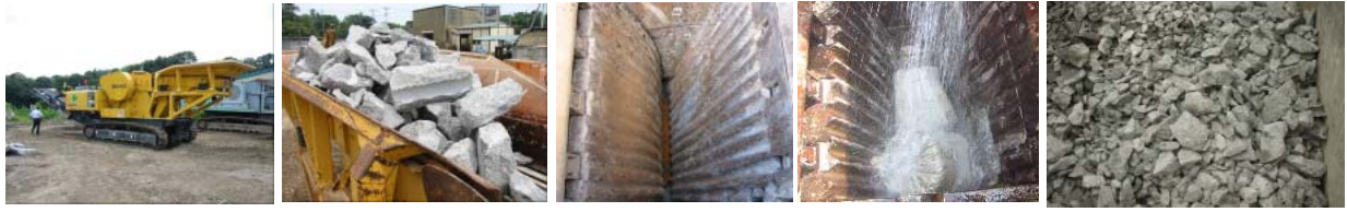
Fig. 2 コンクリート塊の破砕状況 Crushing Concrete for using Gara Packed Concrete
