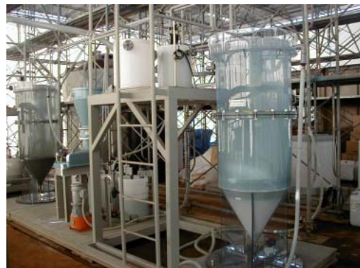
Photo 1 実証プラントの外観
