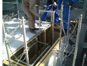
Photo 3 調整ブロック取付 Setting of Adjuster Block
