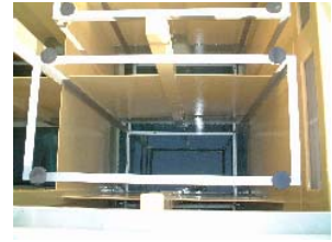
Photo 2 制振室内部 Inside of Partition
