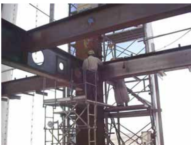
Photo 4 鉄骨工事前ローリングタワー Light Weight Rolling Tower for Steel Frame Work
