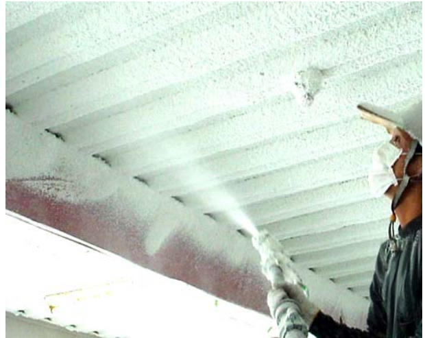
Photo 4 吹付けの様子 Execution of Ceramilite Eco
