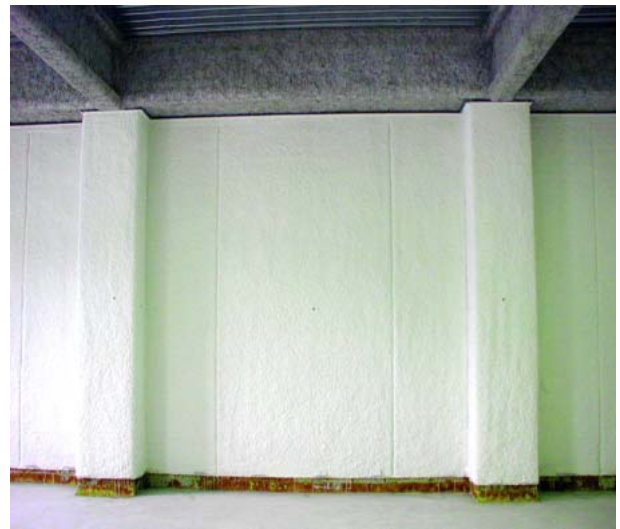
Photo 5 セラミライトエコによる壁面仕上がりの様子 View of Wall Finished up using Ceramilite Eco
