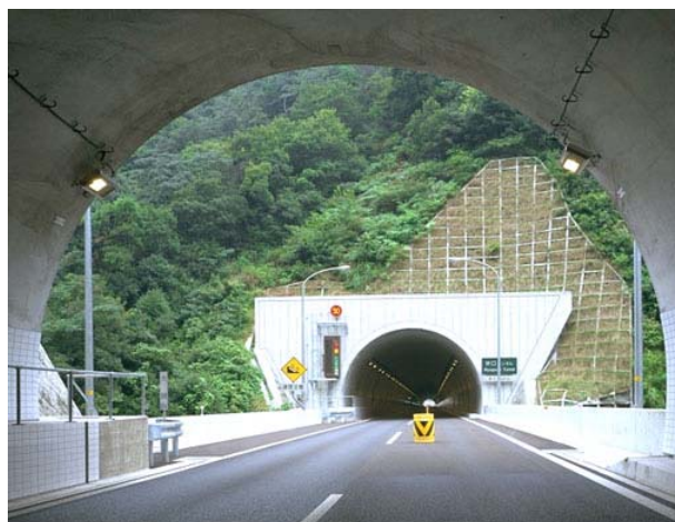
Photo 1 山岳トンネルの例(大頭トンネル) Example for Mountain Tunnel
