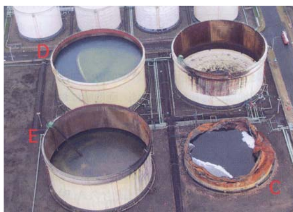
Photo 3 浮き屋根が沈没した4万kl灯油タンク火災 A Fire of 40,000kl Kerosene Tank with Sunken FloatRoof
