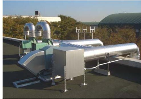
Photo 3 屋外設置した緊急排気システム用ファン
