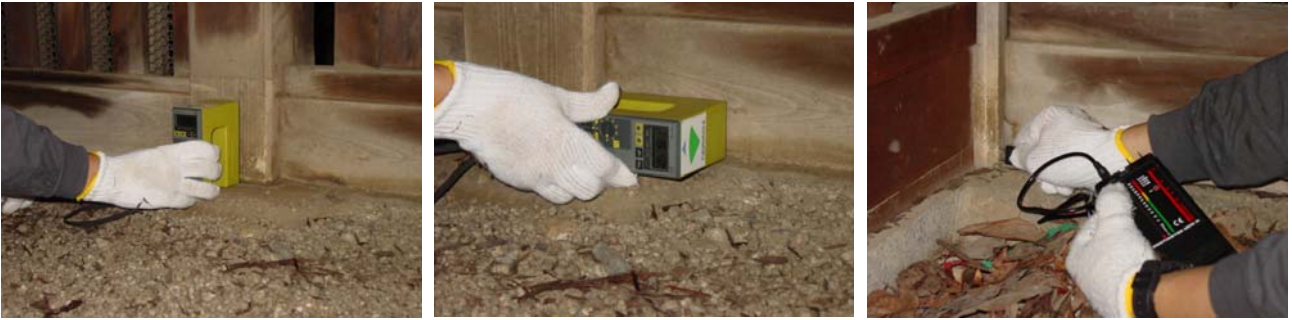
Photo 2 水分計による含水率の測定 Measurement of the Water Content with a Moisture Meter
