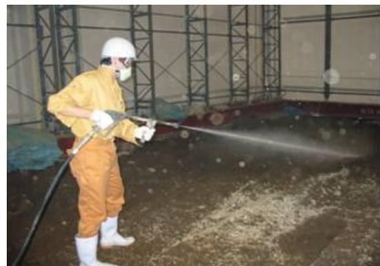
Photo 1 水銀気化抑制剤の散布状況
