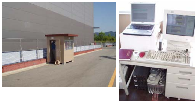
Photo 1 振動監視システム設置例（設置小屋外観・内観） Setting Example in a Small Cabin
